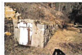
Captage de Riousset travaux Avant / Après
